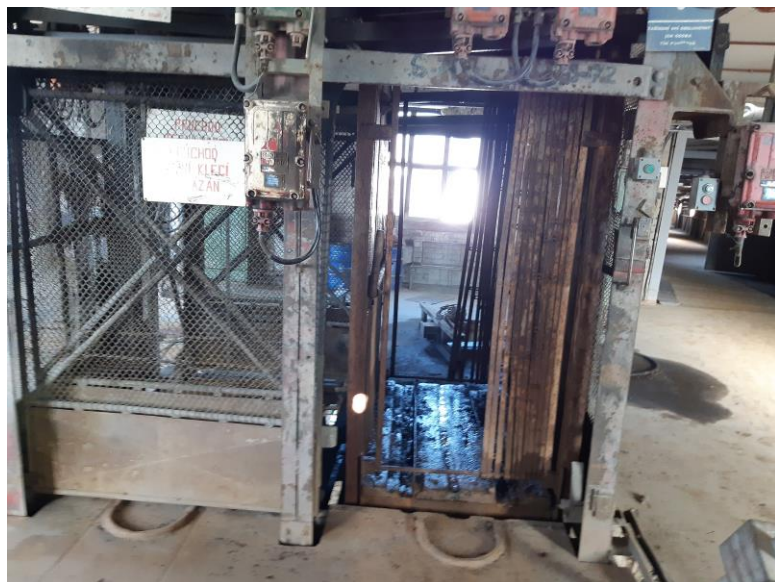
Náraží v šachetní budově
