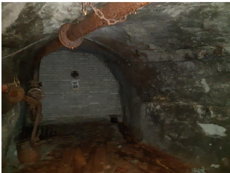
Jedna z uzávěrových hrází těžebního úseku.
