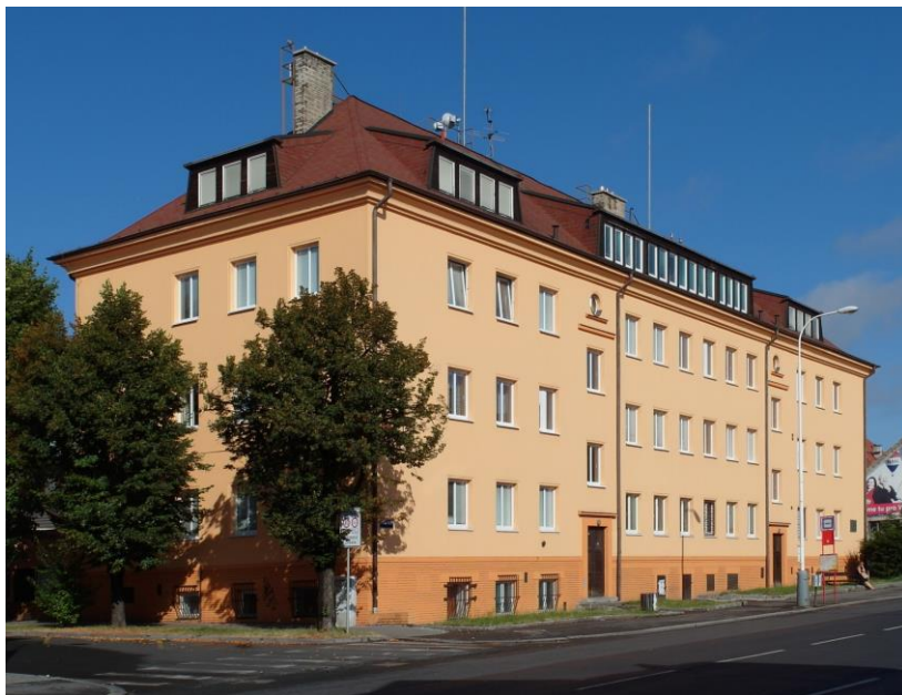
Bývalá budova gestapa a později Okresní národní výbor v Kladně
