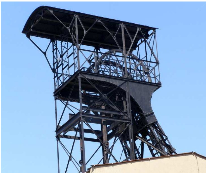
Těžní věž dnes, po opravě, foto J. Grubner
