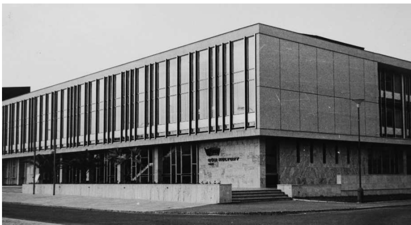
Dům kultury po dostavbě - archiv SVM v Kladně foto J. Velc
