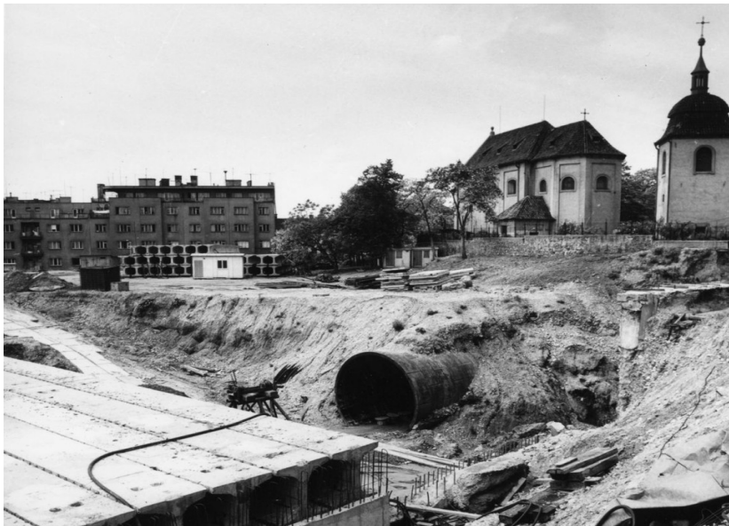
Budování pražského metra, repro z knihy Bennet, David: Metro, příběh podzemní dráhy, Fortuna Print - Praha 2005
