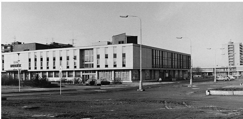
Dům kultury po dostavbě - archiv SVM v Kladně foto J. Velc
