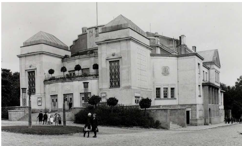
Budova divadla po dokončení, archiv SVMK
