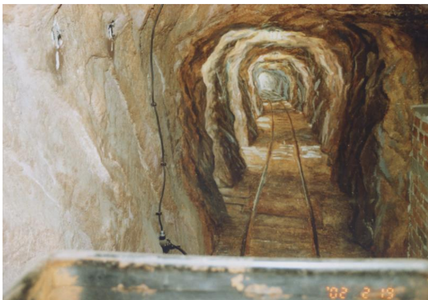
Zbytkové pilíře v rudném dole NTM Praha, foto: NTM
