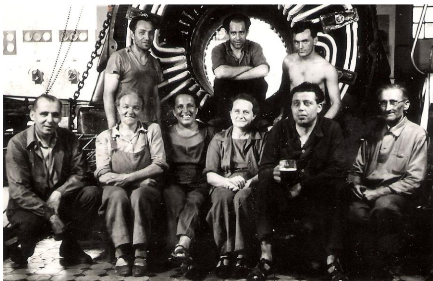
Dùl Theodor, elektrárna, archiv J. Müller.
