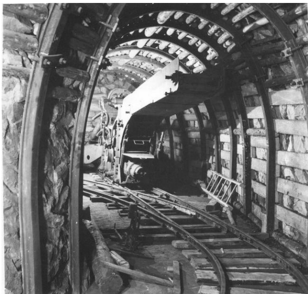
Nakladač systému Westfalia Lünnen, který je umístěn vedle kombajnu Donbas, archiv NTM Praha
