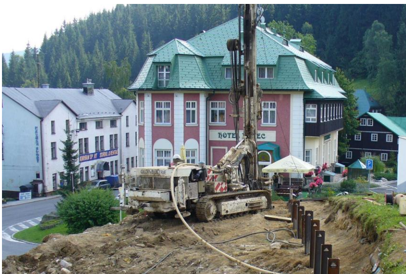
Vrtání a osazování zápor typu I 160 pro zajištění stavební jámy „Info- centrum Pec pod Sněžkou“, foto: archiv Geoindustrie
