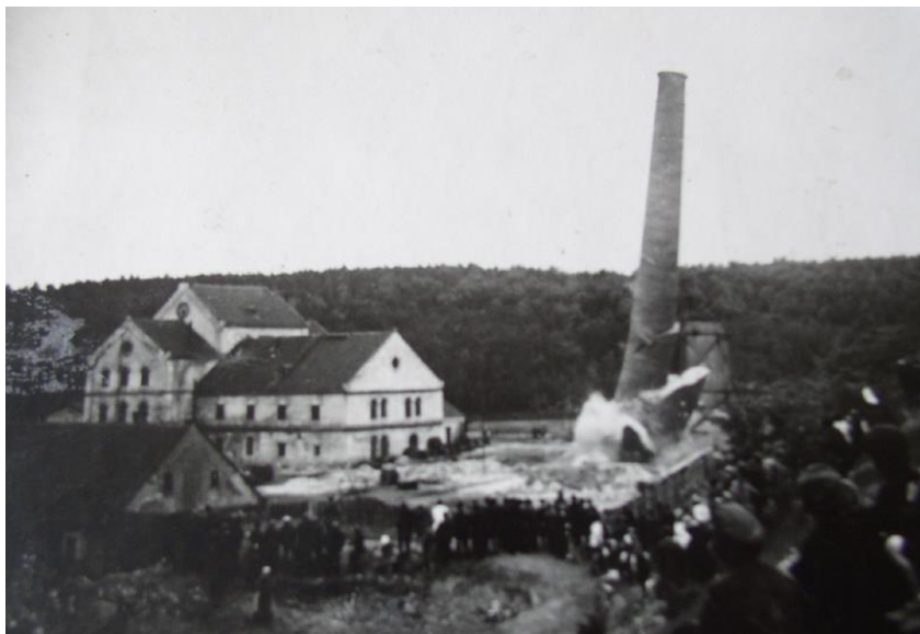
Bourání komína u Dolu Barré, foto archiv autora
