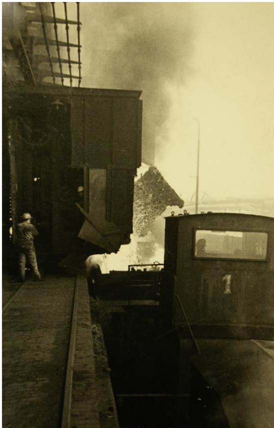
Vytlačování koksu z pece do hasičího vozu, archiv autora
