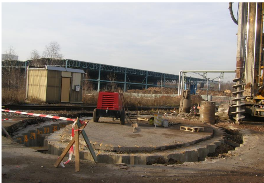
Vrty o průměru 880 mm pro železobetonové piloty, foto autor
