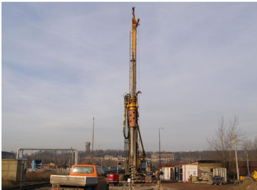
Vrtná souprava při zajišťování ústí jámy, foto autor
