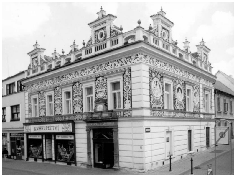
Bývalá lékárna U České koruny po rekonstrukci v 90. letech 20. stol. Foto Jaroslav Vyšín.
