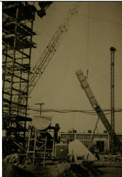
stavba těžní věže
