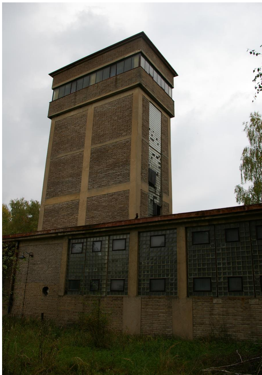
Větrací jáma Pustinka, foto: T. Voldráb
