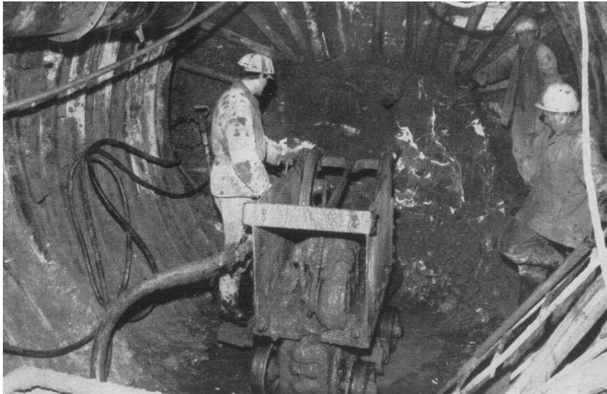
čelba v úseku 13, po injektáži Dukolem
