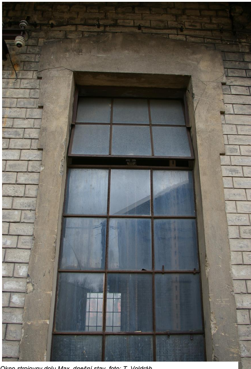
Okno strojovny dolu Max, dnešní stav, foto: T. Voldráb
