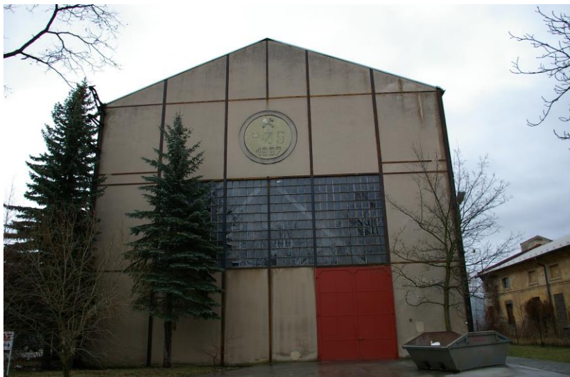
Strojovna dolu Max, dnešní stav, foto: T. Voldráb
