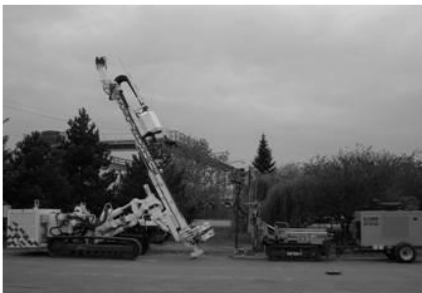
Vrтанé soupravy KLEMM, šikmé vrтанé mikropiloty o průměrech 95 až 250 mm
