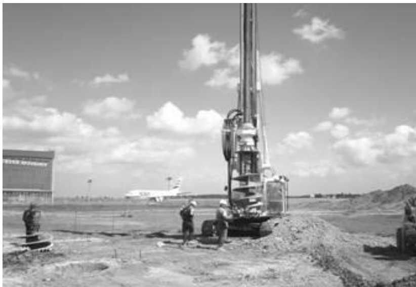
Hasičská stanice, letiště Praha, svislé vrтанé piloty
