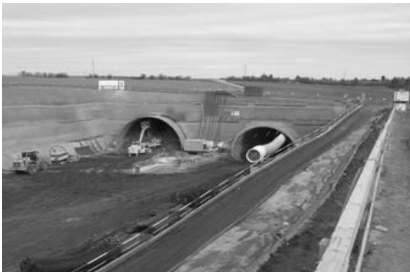
Zajištění portálu tunelu Praha - Lochkov
