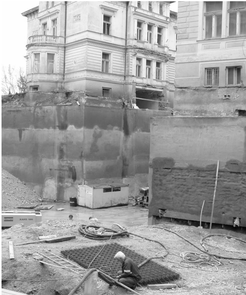
Zajištění stavební jámy, lázeňské domy hotelu Savoy Westend, Karlovy Vary
