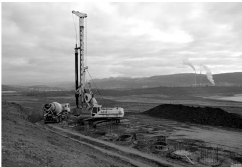
Zajištění svahu velkodolu Chabařovice
