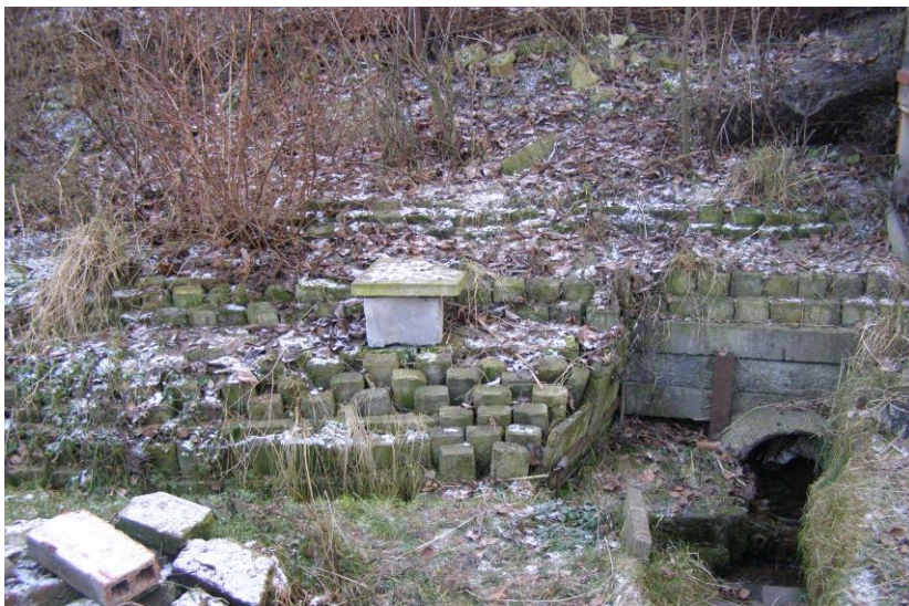
Betonový kanálek na pozemku pana Maxy, kterým je odváděna voda z Hnidouské štoly.
