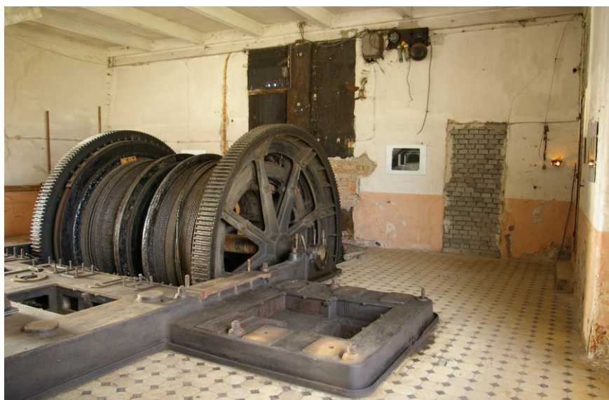
Strojovna Dolu Kúbeck dnes, foto: T. Voldráb
