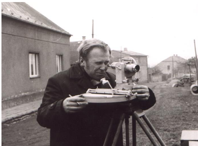
Měření vodovodů a kanalizací v Lánech, foto archiv autora
